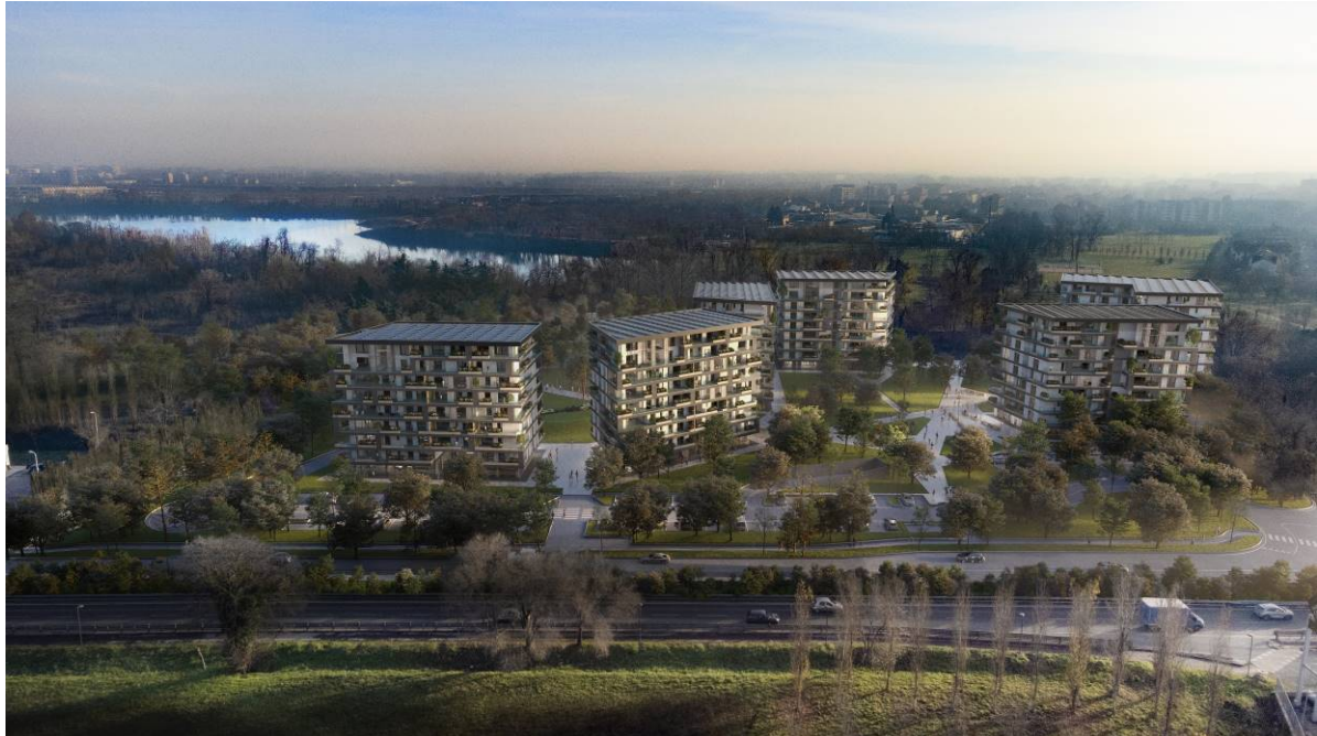
Figura 9 Vista complessiva dell'intero intervento da Nord (Strada Cassanese)
