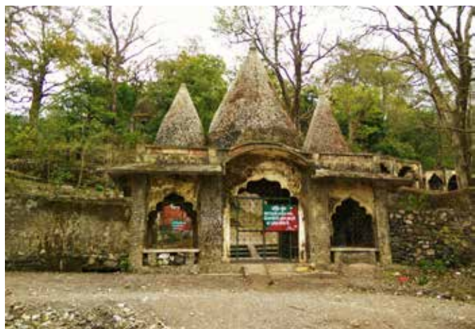
L'ingresso principale dell'Ashram del Maharishi come appariva una decina di anni fa: in stato di abbandono
