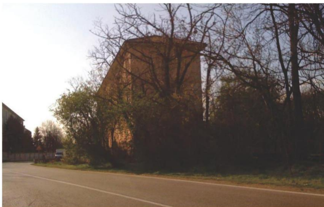
Fig. 3.1.1 – Area di intervento allo stato attuale
