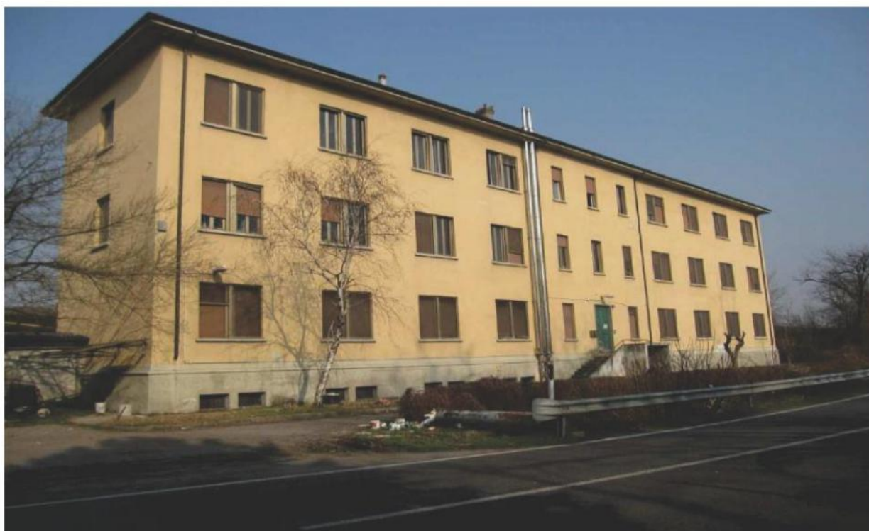
Fig. 1.1 – Edificio da abbattere e ricostruire
