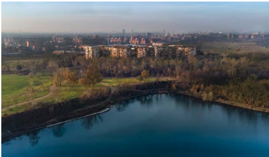
Figura 2-8 – Vista complessiva dell'intero intervento dal lago (alto) e dalla Cassanese (basso)
